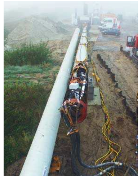
FOT. 3. Uzbrojenie (pompa tunelowa) końca instalowanej rury / fot. Lukas Landesfeind
