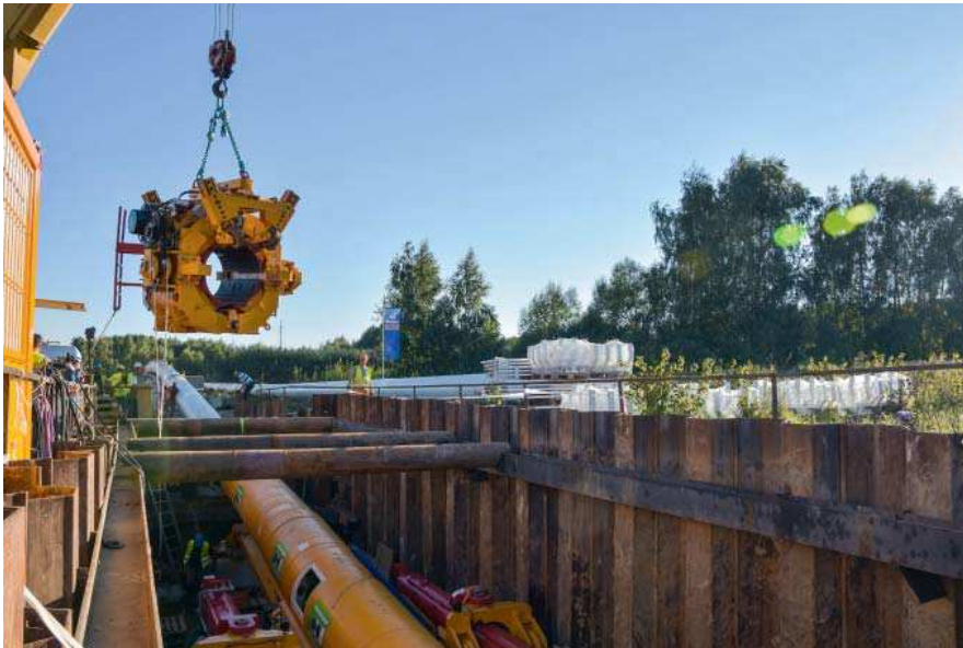
FOT. 2. Montaż elementów Pipe Thruster'a / fot. Lukas Landesfeind
